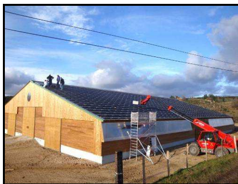
Construction de la centrale solaire photovoltaïque du Gévaudan (Lozère)
