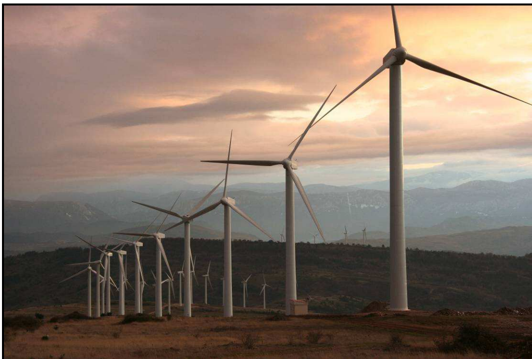
Vue de l'extension du parc éolien de Roquetaillade
