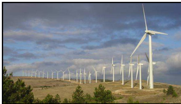
Vue de l'extension du parc éolien de Roquetaillade
