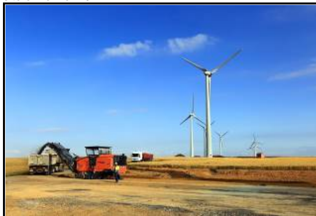
Engins remettant en état le site du parc de Chemin du Bois Hubert ©DavidBlondin
