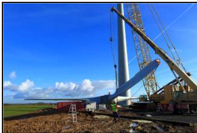
Levage d'une éolienne du parc de Chemin du Bois Hubert ©DavidBlondin
