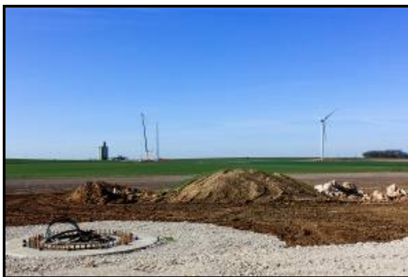
Réalisation d'une fondation d'un parc de La Compagnie du Vent ©ImagesInAir
